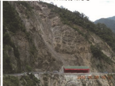
台8臨37線13k+900鋼構明隧道
