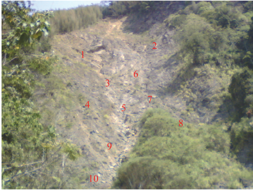
圖 25 達邦三號橋邊坡及監測點位
