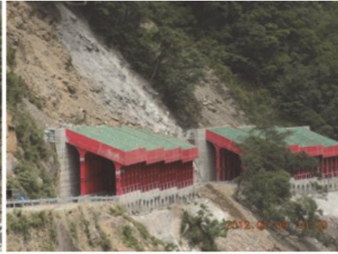
台8臨37線13k+800鋼構明隧道
