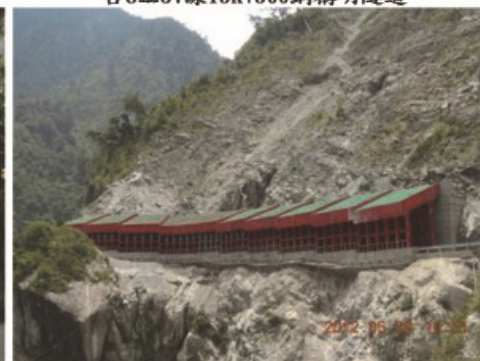
台8臨37線16k+400鋼構明隧道
