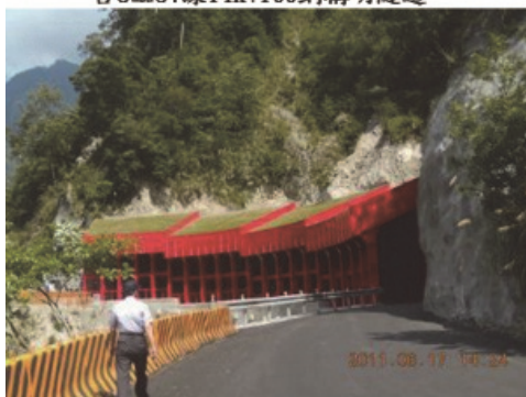
台8臨37線15k+100鋼構明隧道
