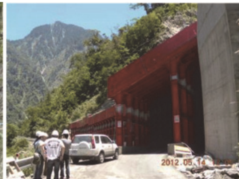
台8臨37線15k+500鋼構明隧道
