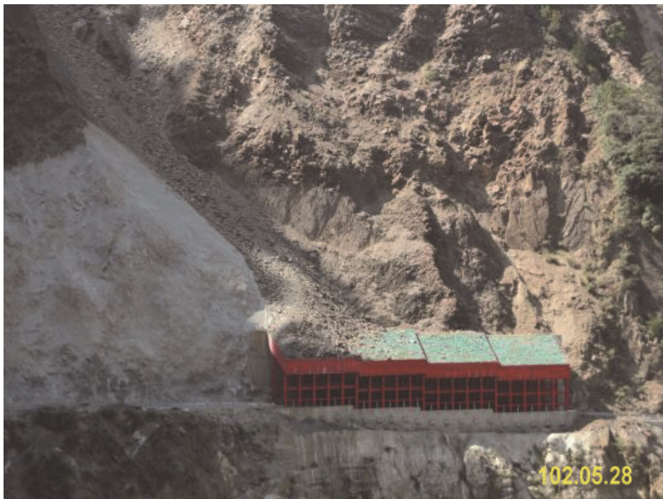
台 8 臨 37 線 13k+900 段噴凝土保護
