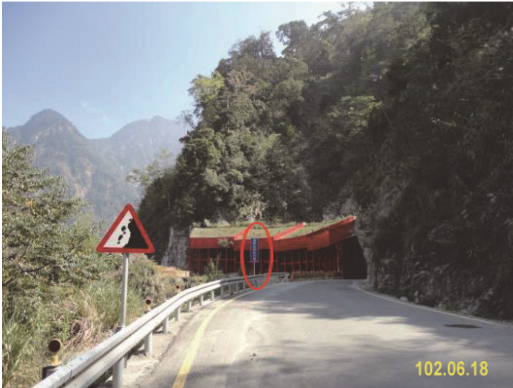
台 8 臨 37 線 15k+100 段緊急避難空間
