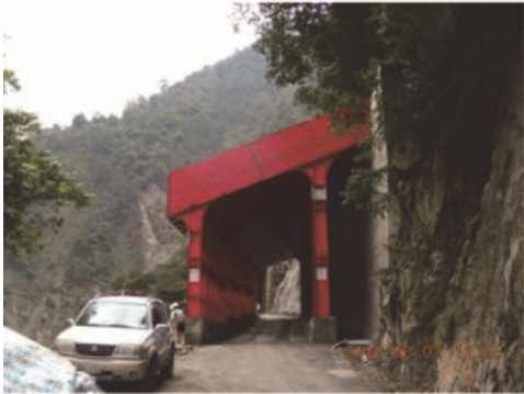
台8臨37線13k+700鋼構明隧道
