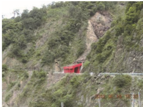
台8臨37線14k+100鋼構明隧道
