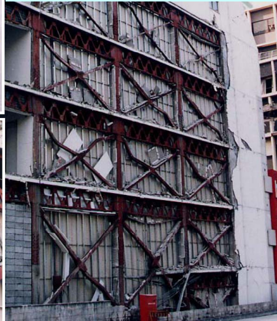
傳統鋼骨同心斜撐破壞 實例(1995年阪神地震)
