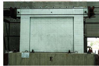
圖 4-18 A14 試體層間變位 0.5% pull (1 st )之照片
